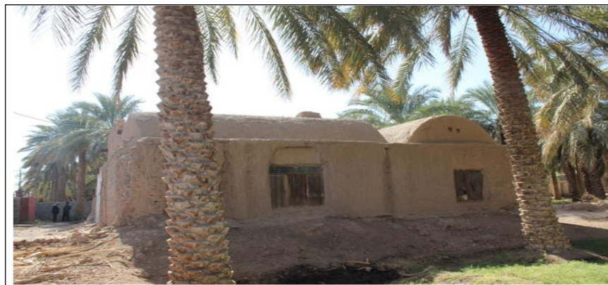
شکل ۷. الگوی مسکن کوچک و زیبا در روستای دولت‌آباد، ساخت و ساز با مصالح بومی (سقف گنبدی)
